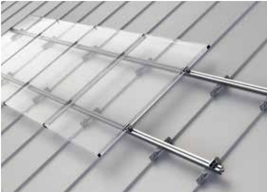
Rivikatoilla kiinnike asennetaan katon saumaan.
